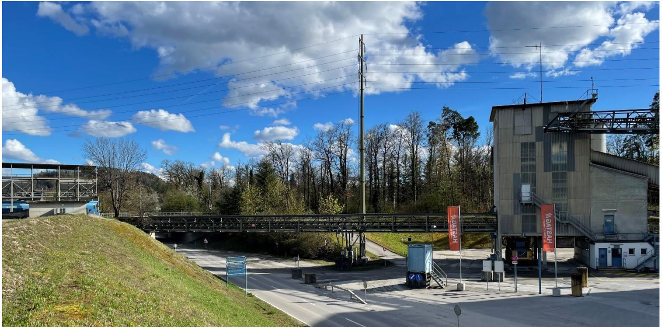
Abb. 3 Bestehendes Förderband über die Rüdlingerstrasse
