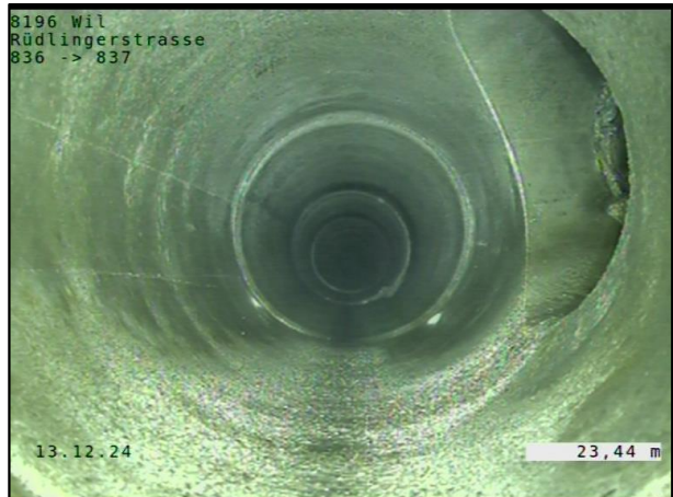
23.19 m Anschluss mit Formstück 3 Uhr Foto 4
