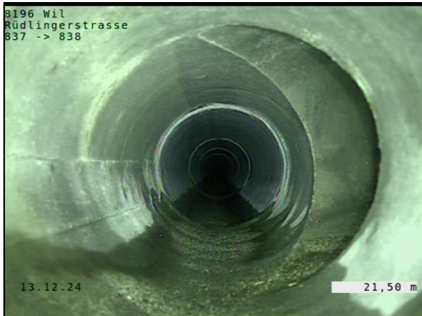
21.33 m Anschluss mit Formstück 3 Uhr Foto 3
