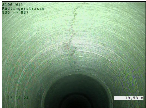
19.53 m Riss längs 12 Uhr Foto 2
