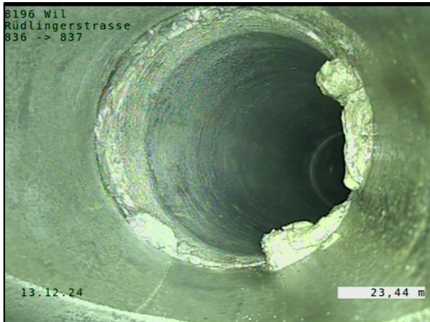
23.19 m Anschluss mit Formstück 3 Uhr Foto 3
