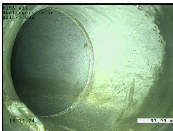
37.99 m Richtungsänderung nach links Foto 6
