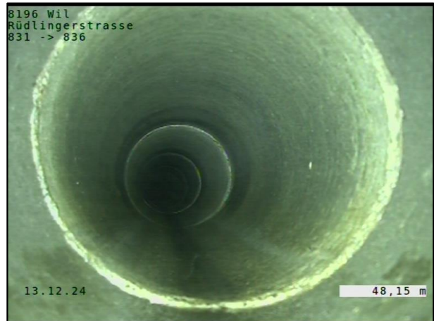
48.15 m Richtungsänderung nach links Foto 8
