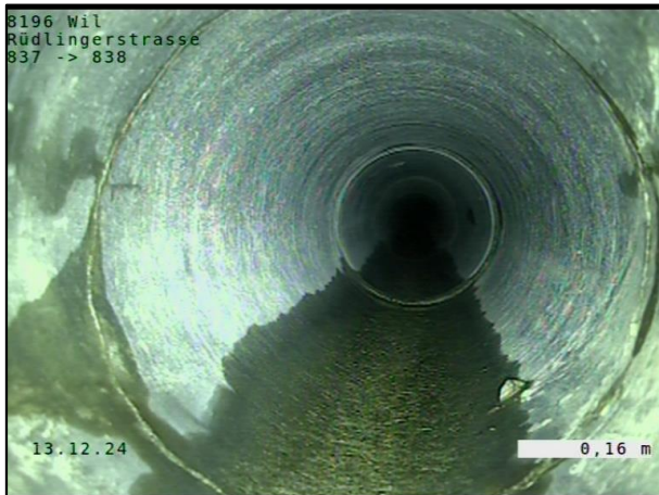
0.16 m Riss radial 12 bis 12 Uhr Foto 1
