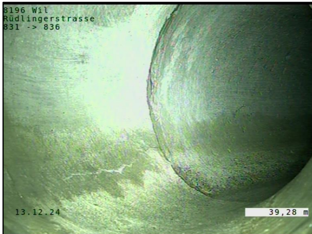
39.28 m Richtungsänderung nach rechts Foto 7
