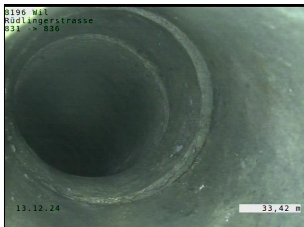
33.05 m Anschluss eingespitzt 9 Uhr Foto 3
