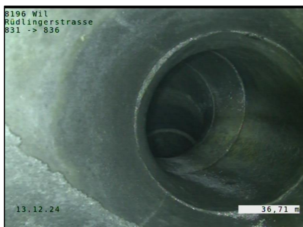
36.57 m Anschluss mit Formstück 3 Uhr Foto 5
